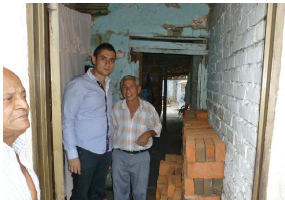
Consecución de Ladrillos para arreglo de vivienda
