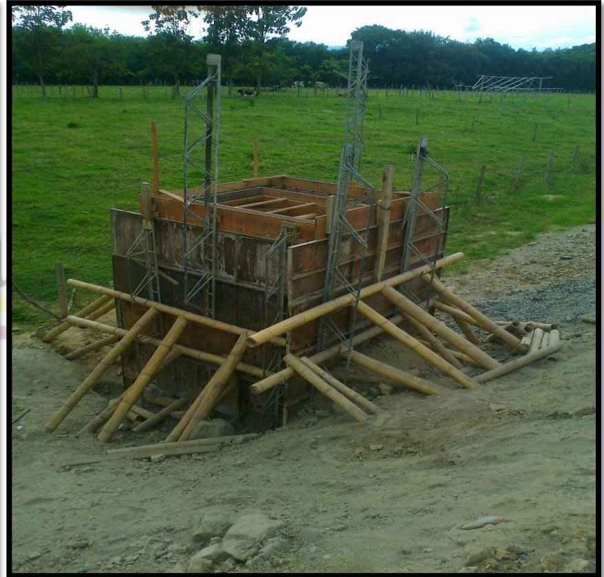
CONSTRUCCIÓN RECAMARA DE DRENAJE
