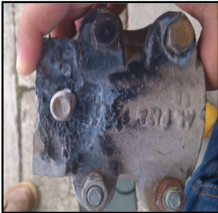
CORRECCIÓN DE PUNTO CALIENTE EN CONECTORES
