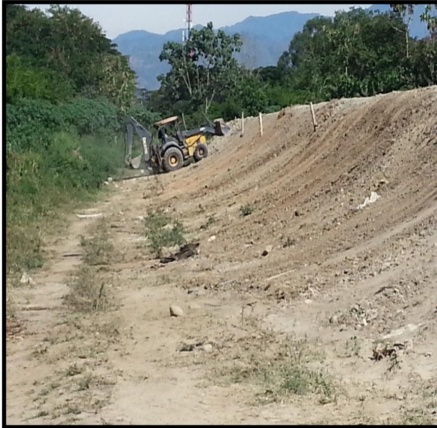
CONFORMACION TALUDES DEL DIQUE
