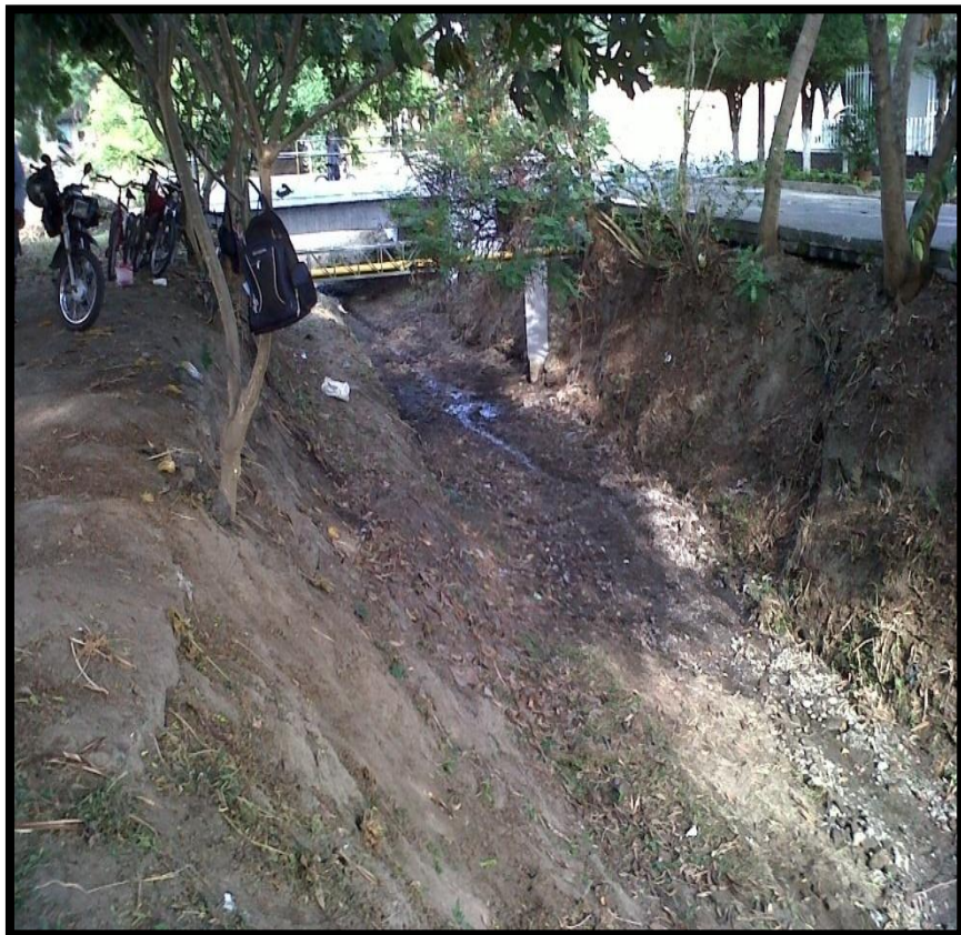
ZANJÓN LAVAPATAS SECTOR EL SAMAN
