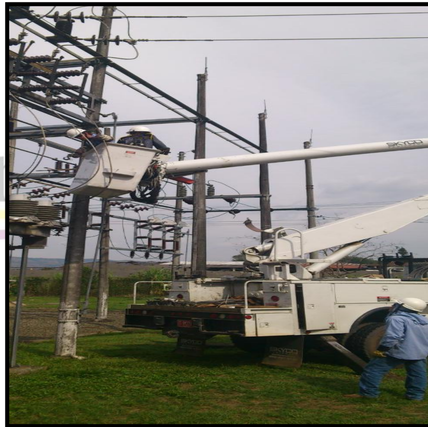
CORRECCIÓN DE PUNTOS CALIENTES CON GRUA DE BRAZO AISLADO HIDRAULICO
